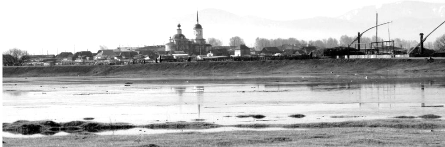
Фото 1 – Твороговская церковь Казанской иконы Божьей Матери. На переднем плане водозащитная дамба, построенная в 1939 г. и защищающая село от наводнений (Фото автора)
