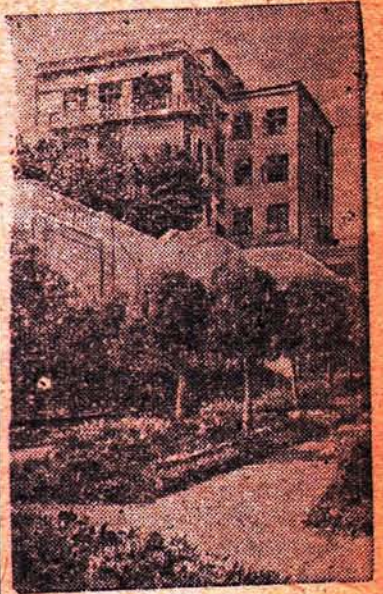
На Кисловодском курорте в этом году будет отдыхать и лечиться свыше 115 тысяч трудящихся. Уже работают более 40 санаториев. На снимке: один из корпусов санатория Министерства сельского хозяйства СССР в Кисловодске.
