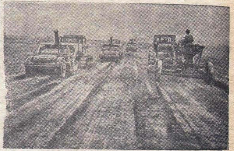
ХЕРСОНСКАЯ ОБЛАСТЬ. Колхоз имени Ворошилова Каховского района первым приступил к строительству оросительной системы по новому методу. Проект орошаемого участка разработал гидромелиоратор комсомолец В. Фортунатов. На первом участке, площадью в 40 гектаров, работают скреперы, грейдеры, бульдозеры, которые разравнивают грунт и делают насыпи для центральной оросительной магистрали. На снимке: на участке строительства оросительной системы. Фото Ю. Лихуты. Прессклише ТАСС
