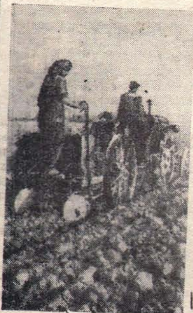
В колхозах Закарпатья в этом году впервые начали применяться картофелесажалки. На снимке: механизированная посадка картофеля в сельхозартели имени Калинина Береговского округа. Фото Л. Ковгана.
