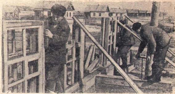
Хабаровск. В колхозе имени Горького Сталинского района идет большое жилищное и хозяйственное строительство. Сейчас здесь строятся 10 жилых домов, детские ясли, овощехранилище. На снимке: строительство детских яслей.
