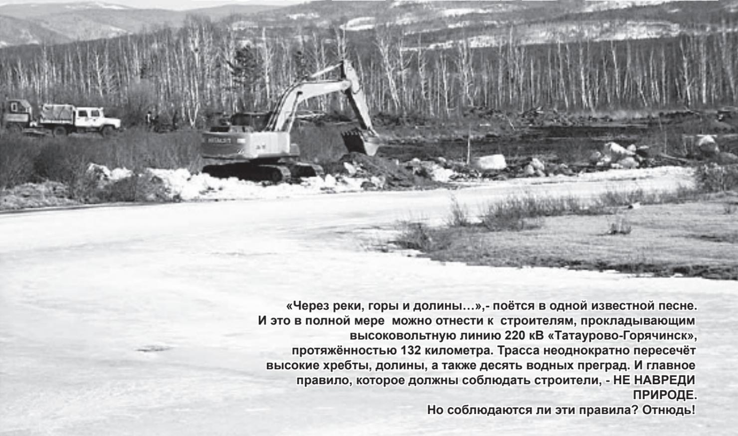
«Через реки, горы и долины...»,- поётся в одной известной песне. И это в полной мере можно отнести к строителям, прокладывающим высоковольтную линию 220 кВ «Татаурово-Горячинск», протяжённостью 132 километра. Трасса неоднократно пересечёт высокие хребты, долины, а также десять водных преград. И главное правило, которое должны соблюдать строители, - НЕ НАВРЕДИ ПРИРОДЕ.
