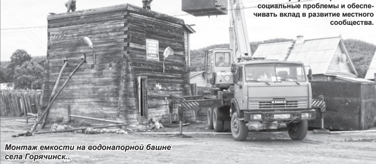
Монтаж емкости на водонапорной башне села Горячинск.
