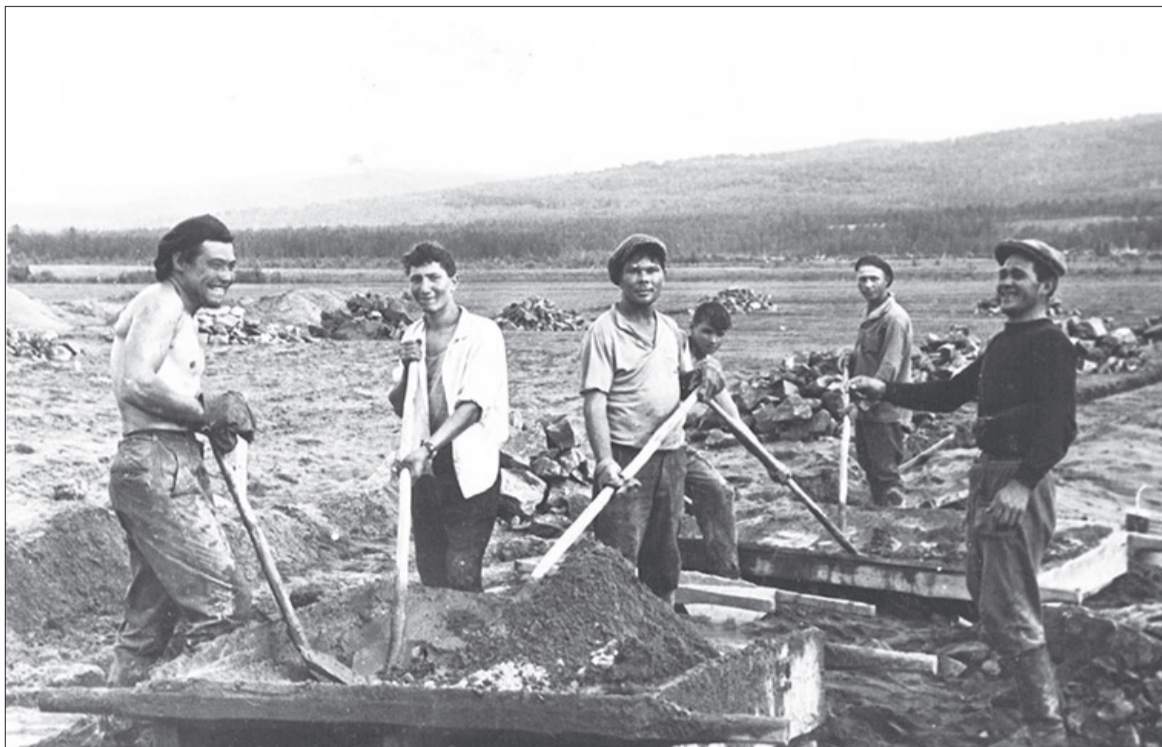
На строительстве производственной базы ПМК.
