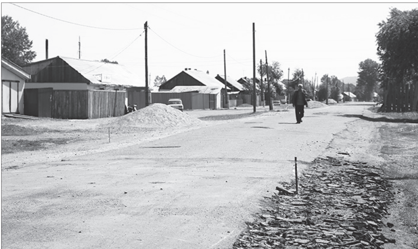
Подготовительные работы для ремонта асфальтового покрытия проведены, и скоро ильинскую улицу Коммунистическая будет не узнать.
