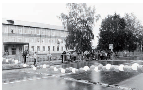
Ремонт ул. 50 лет Октября в райцентре
