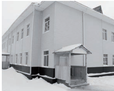
Введена в эксплуатацию начальная школа в Ильинке
