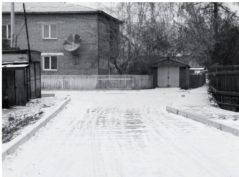
Обустройство придомовой территории на ул. Оболенского с. Турунтаево
