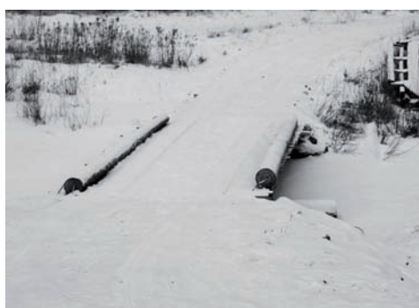
Построен мост в Еловке
