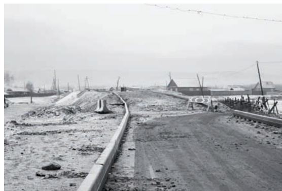
Строительство моста в Турунтаево
