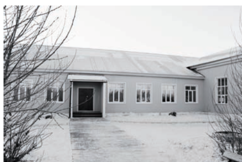
Отремонтирована школа в с. Нестерово
