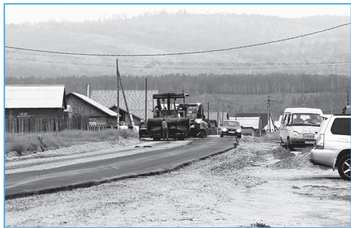
Асфальтируется ул. Калинина в с. Турунтаево.
