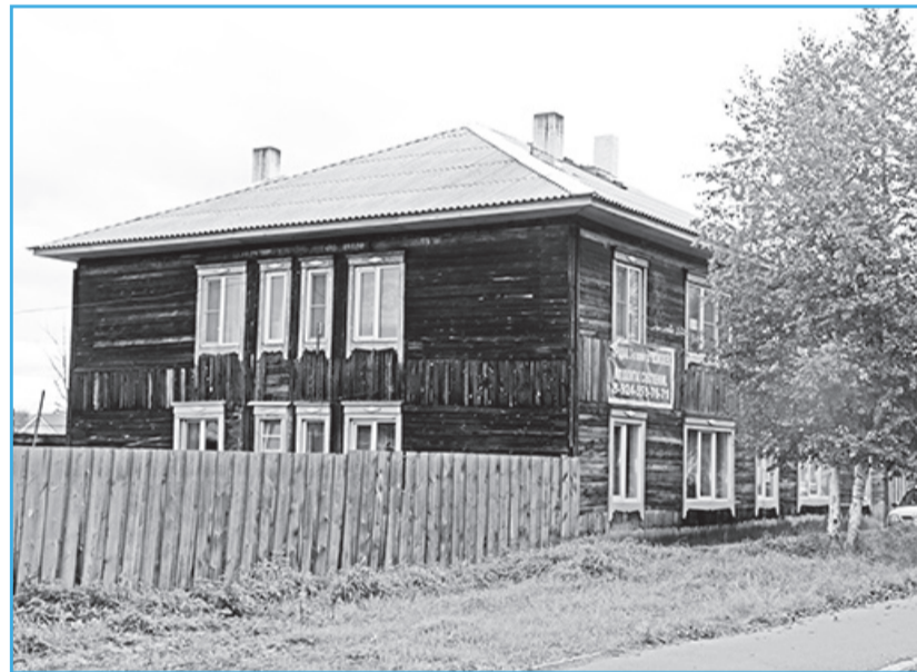
с. Турунтаево, новая крыша дома по улице «50 лет Октября».
